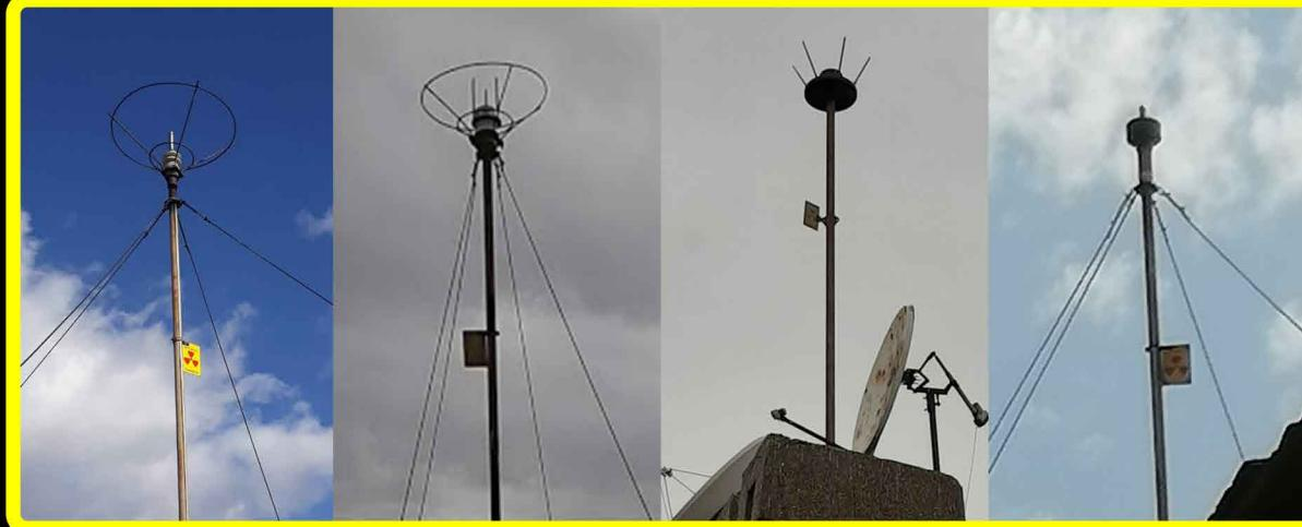
Slika 1: Četiri tipa gromobrana sa radioaktivnim izvorom
